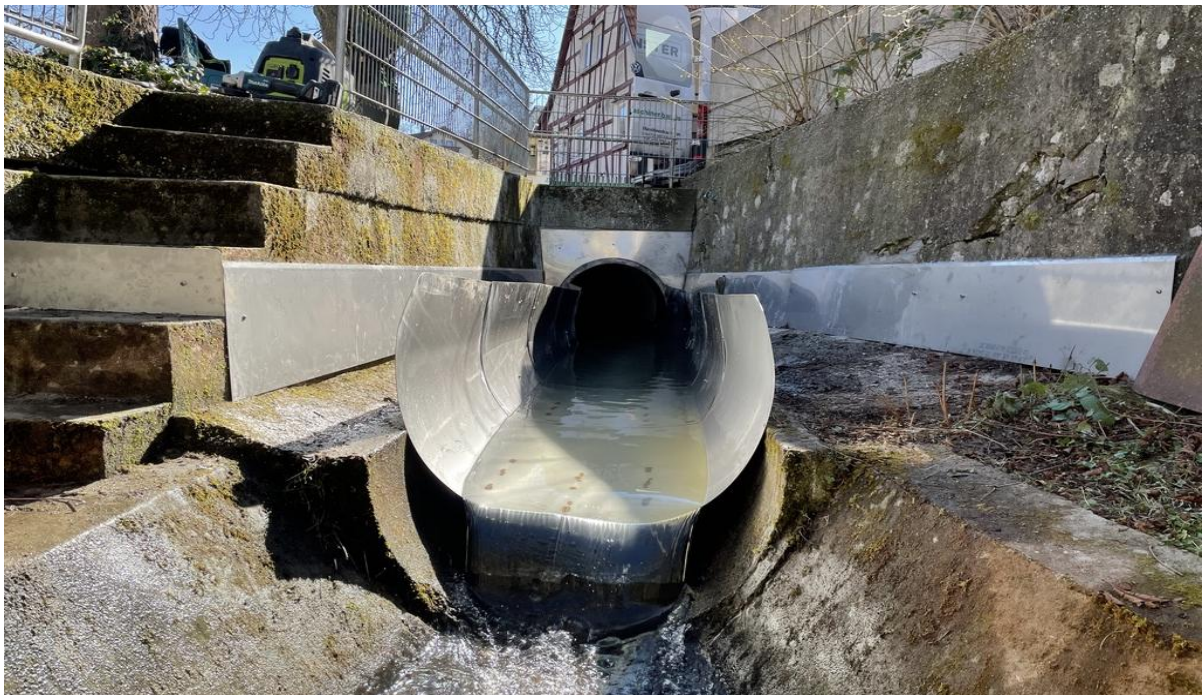
Abb. 1: Sperre Mumbach, in einem Feuerwehr-Stau in Verdolung. Bj. 2023, Baukosten ca. 13 T€
